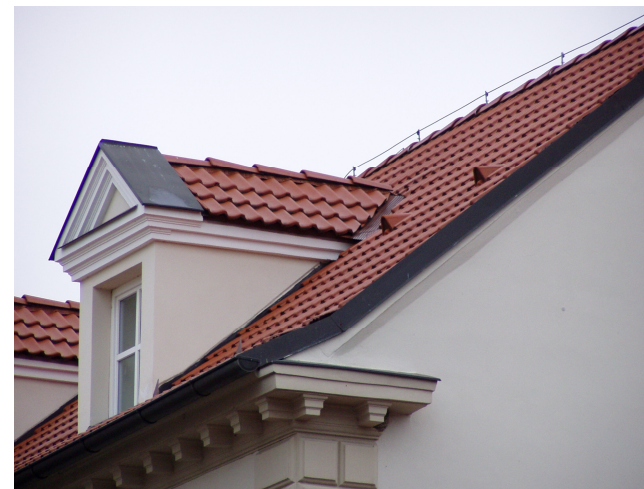
Detail vikýře na západním průčelí domu
