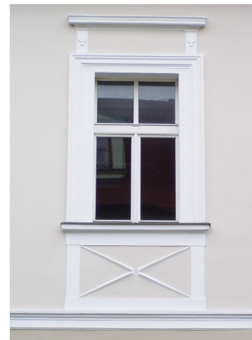
Detail okna uprostřed v patře hlavního průčelí domu
