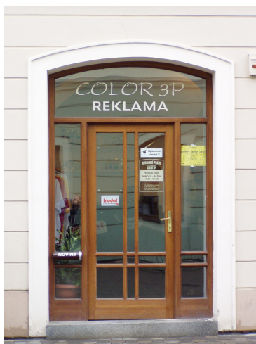
Detail prosklených dveří - severní průčelí domu
