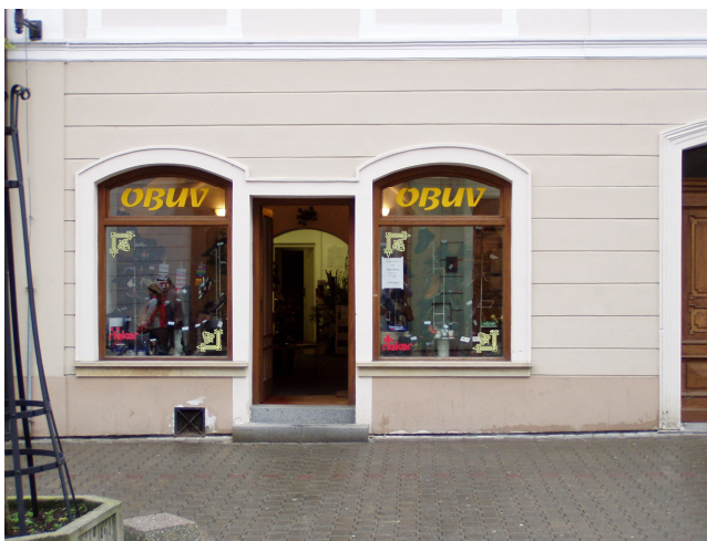
Detail přízemí s výkladci na severním průčelí domu
