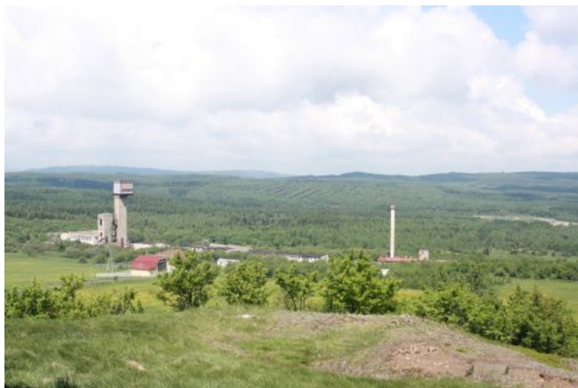
pohled od jihovýchodu, průhled k dolu Měděnec přes pinkoviště v dolní části vrchu, 2012
