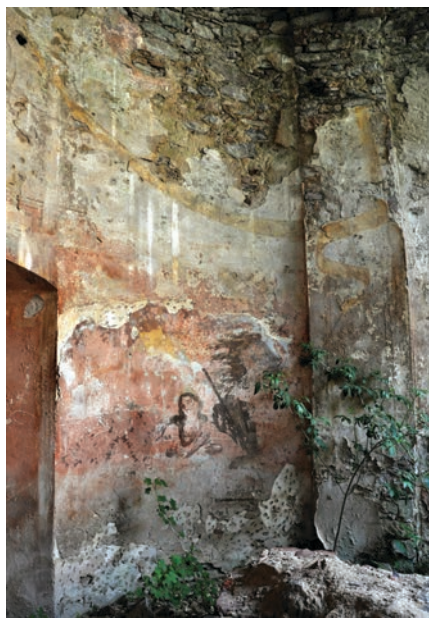
Obr. 20. Bílý Kostelec, kostel sv. Havla, závěrová strana presbytáře, díky degradaci svrchní šablonové malby z 19. století se na povrchu omítek projevují torza originální figurální a ornamentální výzdoby presbytáře, v závislosti na celkovém havarijním stavu objektu však dochází k rychlé ztrátě detailů a ploch maleb. Foto: Táňa Nejezchlebová, 2012.
