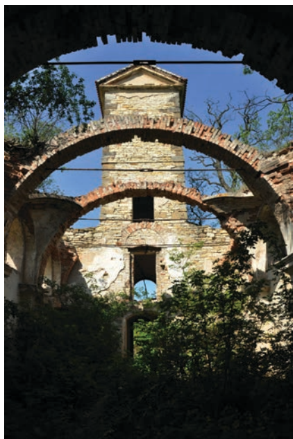
Obr. 17. Encovany – Prachová, kaple sv. Václava, z klenby lodi se dochovaly pouze meziklenební pasy a koutové náběhy nasazené na přízední pilastry. Foto: Táňa Nejezchlebová, 2012.
