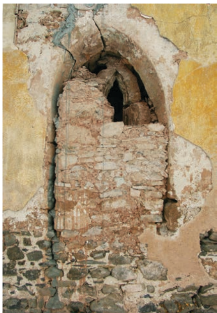
Obr. 13. Lubenec – Libyně, kostel sv. Jiljí, závěrový bok presbytáře, při částečné destrukci zazdívky gotického okna bylo ve světlém otvoru odhaleno kamenné ostění s jeptiškou, pocházející zřejmě z počátku výstavby kostela v 1. polovině 14. století. Foto: Táňa Nejezchlebová, 2011.
