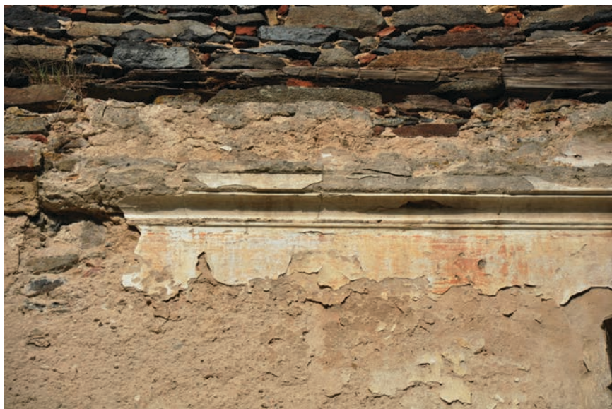
Obr. 14. Bílý Kostelec, kostel sv. Havla, interiér lodi, z plochého stropu kostela se dochovaly pouze omezené úseky štukového profilovaného fabionu s relikty barevných nátěrů ve více vrstvách. Foto: Táňa Nejezchlebová, 2012.
