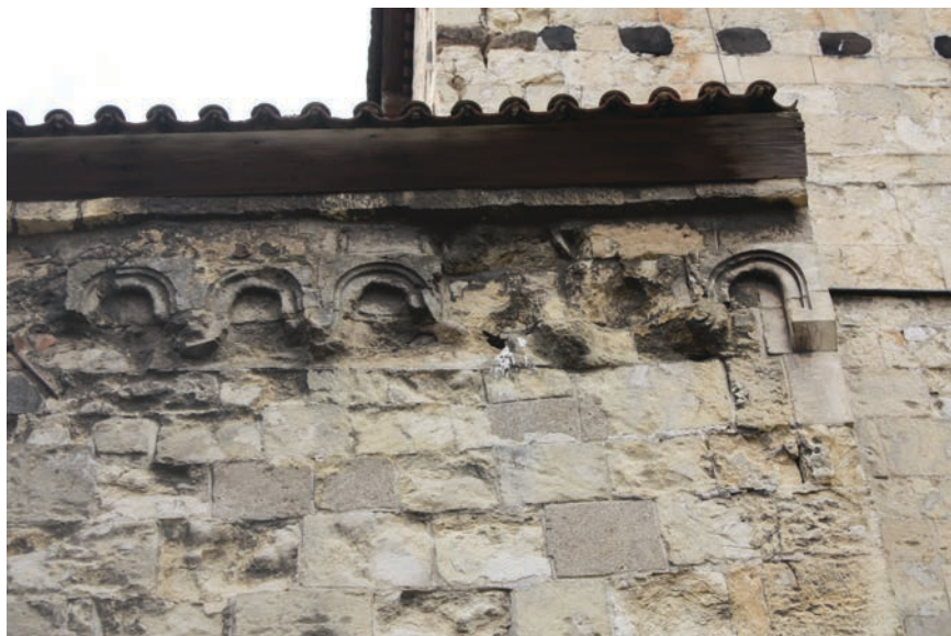
Obr. 11. Libčeves, kostel Stěti sv. Jana Křtitele – detail destrukce románského obloučkového vlysu pod hlavní římsou kostela. Stavba nemá okapy, voda ze střechy volně stéká právě na tyto partie stavby. Foto: Lucie Radová, 2009.
