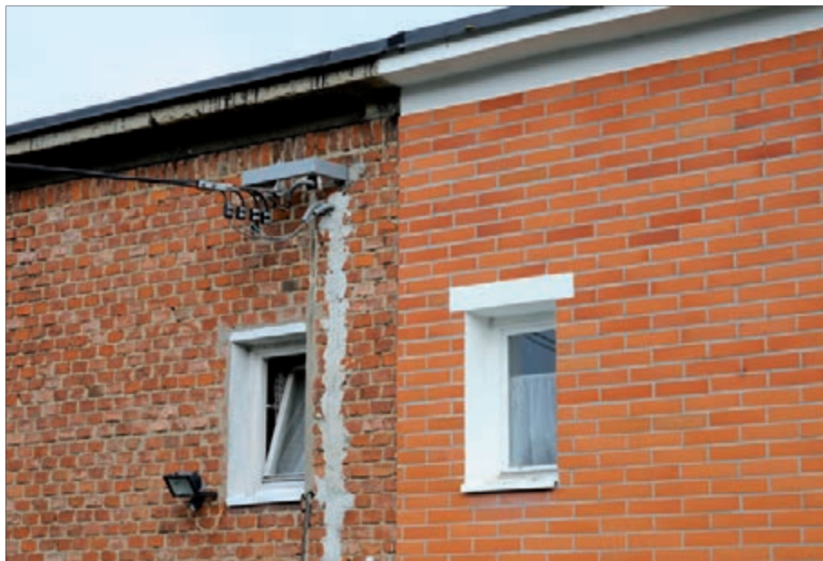
Rozdíl originální režné fasády a obkladu keramickými pásky vyniká zoláště při detailním pohledu.
