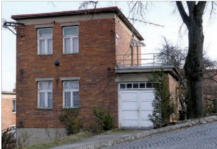
Originální podoba baťovského domku s režnou cihlovou fasádou.
