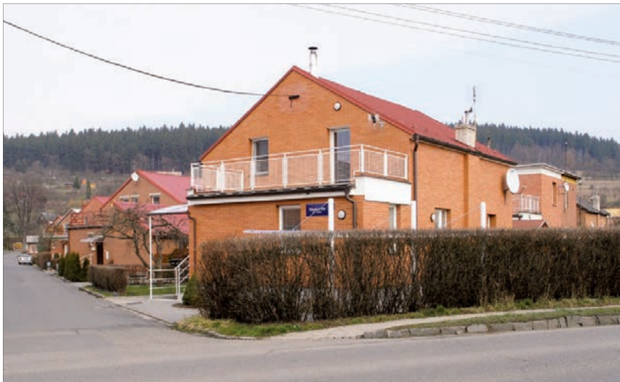
Nové obklady se zcela potlačeným spárováním.
