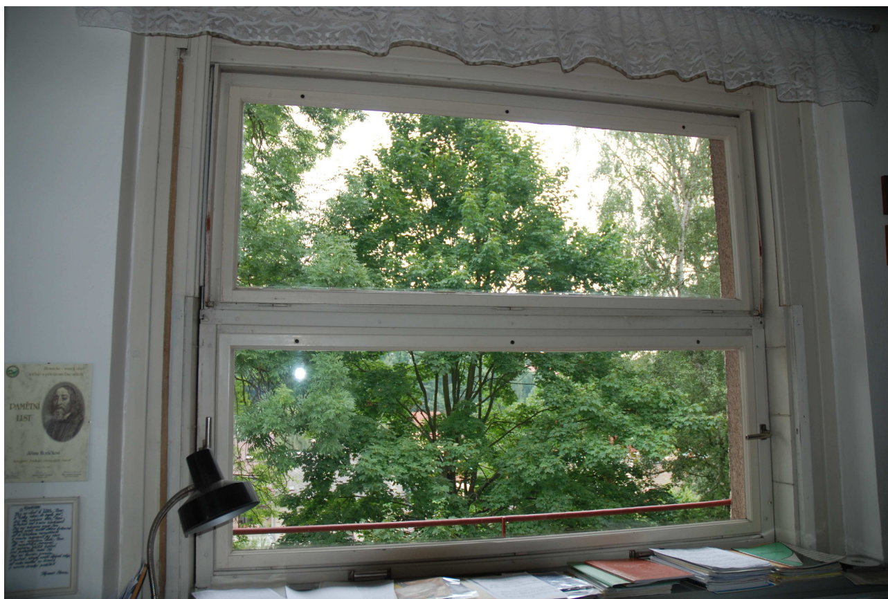
Foto 080826ps DSC_0094 – detail výsuvného okna patra východního průčelí
