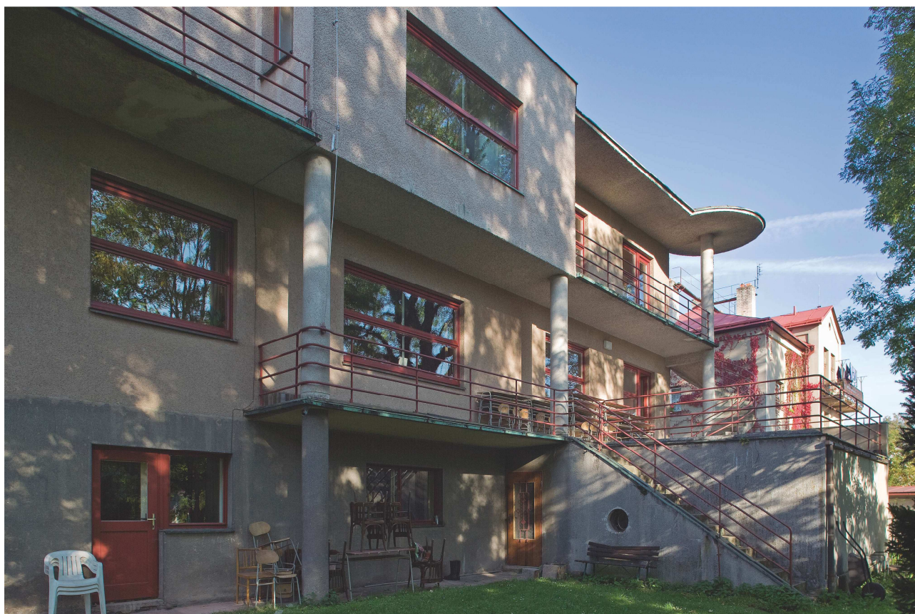
Foto Jungmann 2007 – pohled od jihovýchodu, detail východního průčelí
