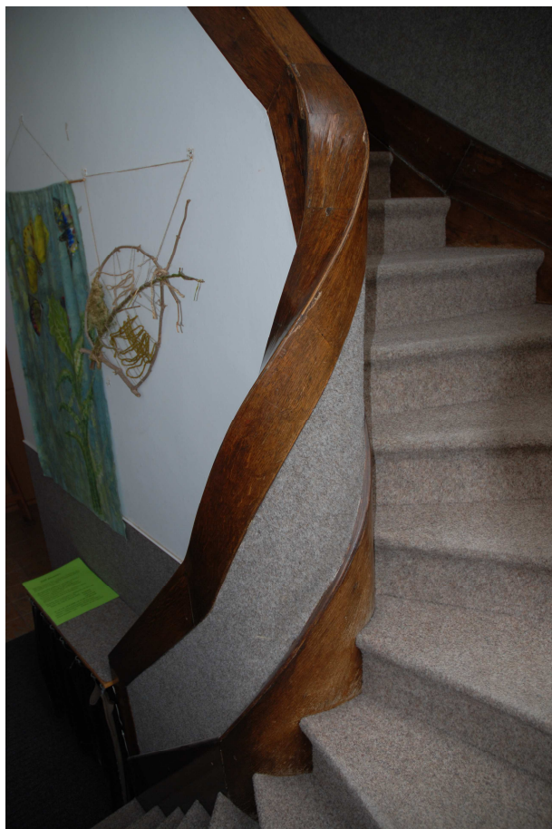
Foto 080826ps DSC_0079 – detail zábradlí schodiště
