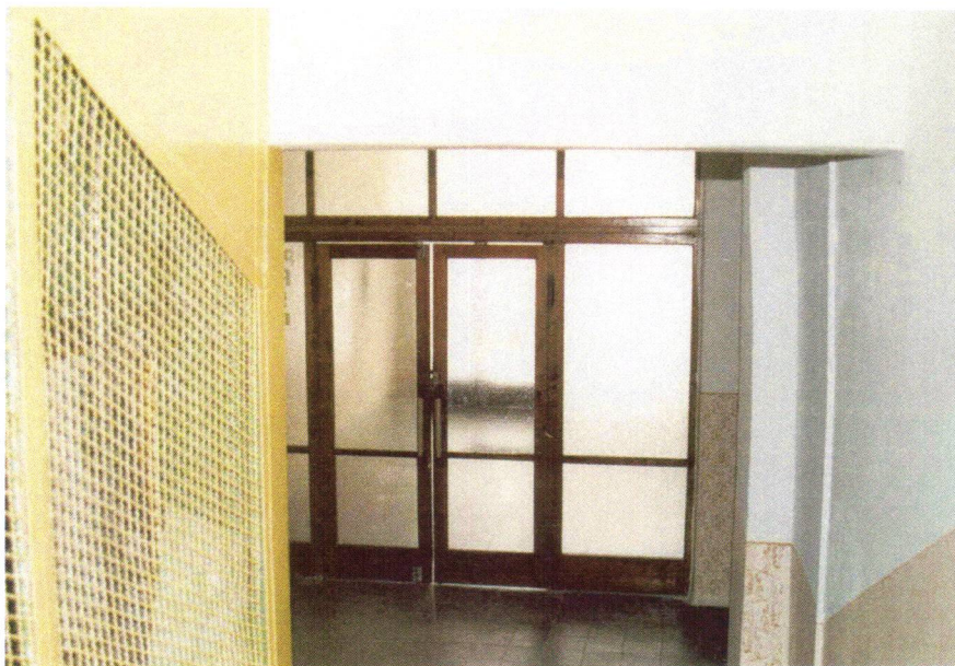
interiér – prostor chodby v přízemí
