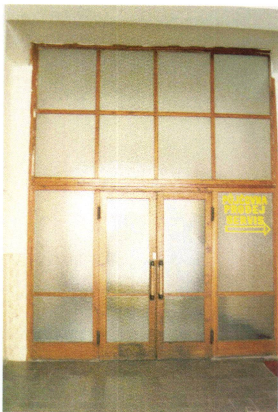
interiér – prostor chodby, dosud bez přiděleného č. neg.
