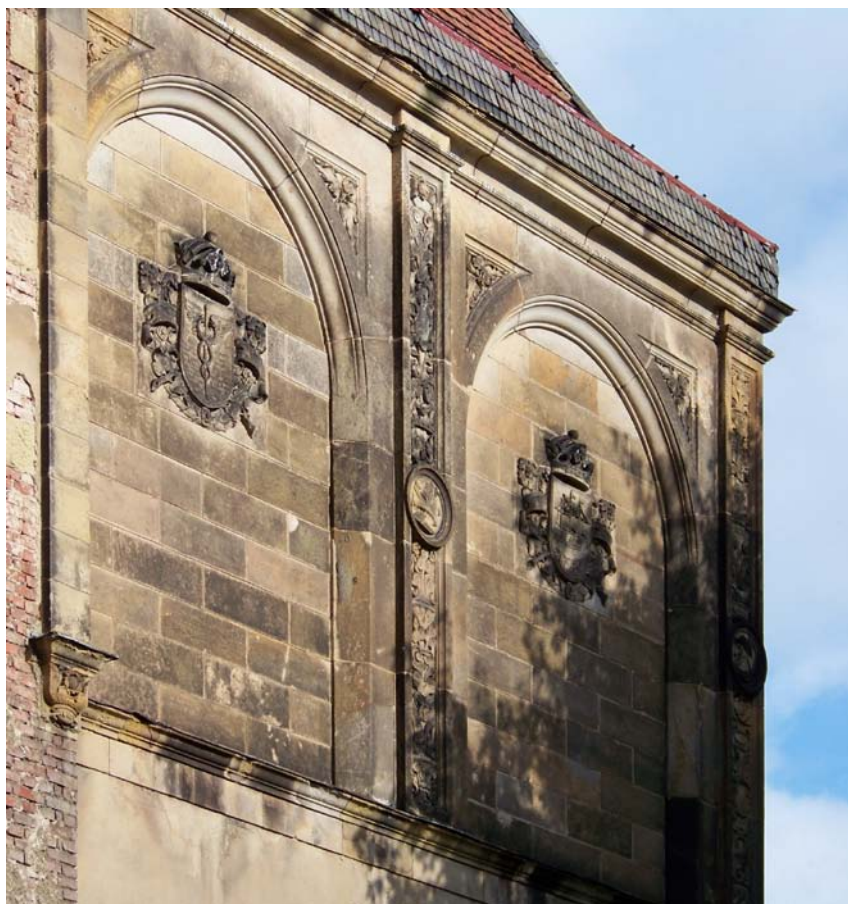
Náročná kamenická výzdoba dvorní fasády zasedací síně směrem do ulice U Obchodní komory.
