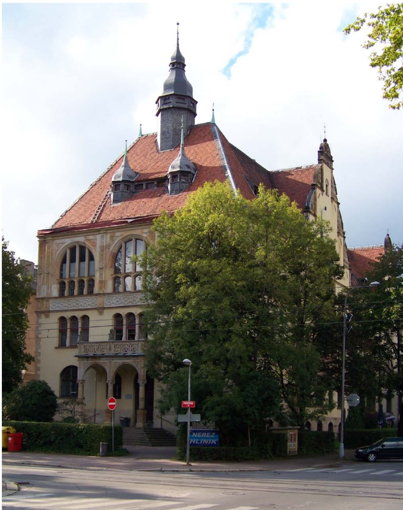
Hlavní průčelí obrácené do Masarykovy ulice.
