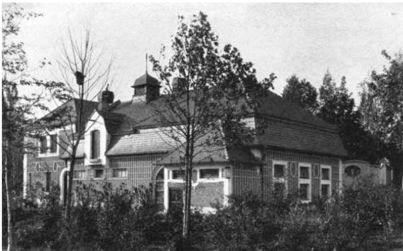
Domek správce se stájemi krátce po dostavbě. Wiener Bauindustrie Zeitung 1912, roč. 29, s. 410.
