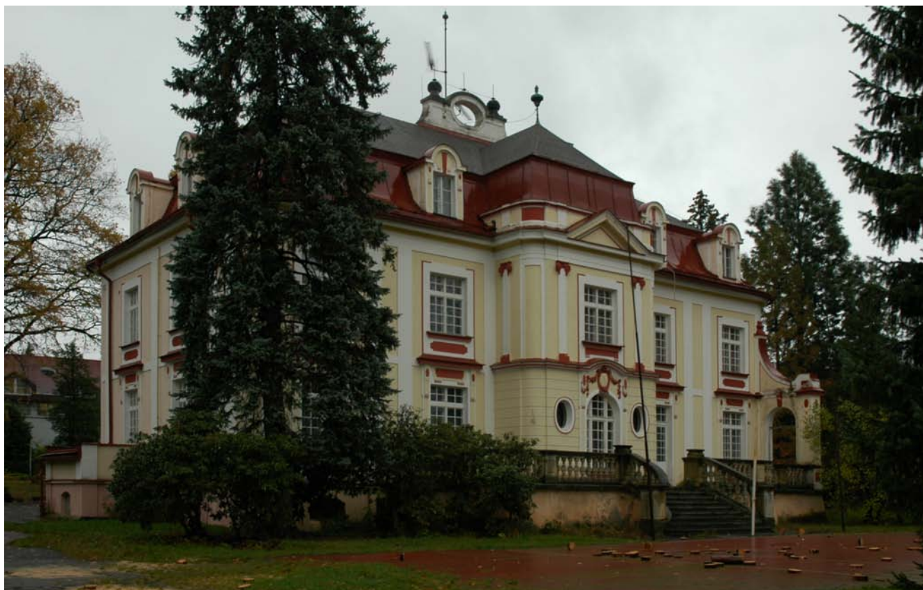
Zahradní průčelí, pohled od jihozápadu. Foto Jan Dostálík.
