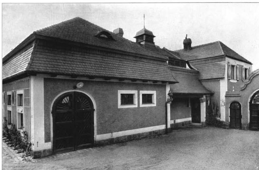
EINFAHRT UND STALLGEBÄUDE ZUM HERRENHAUS FELIX CZIŽEK VON SMIDAICH IN HAINDORF.
