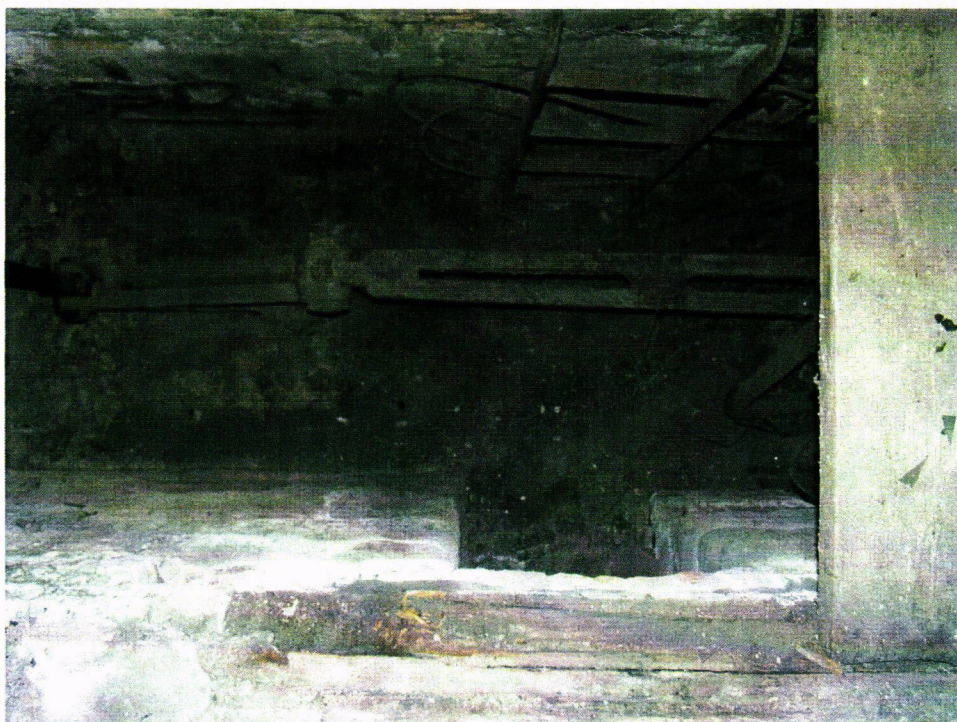
Střekov, obec Ústí nad Labem, okres Ústí nad Labem, Ústecký kraj, drážní parní vodárna čp. 822, interiér přízemí – „pumpárny“, pohled do šachty (západně za parním strojem) na převodní mechanismus přenášející sílu parního stroje na vodní čerpadlo v cisterně vpravo
