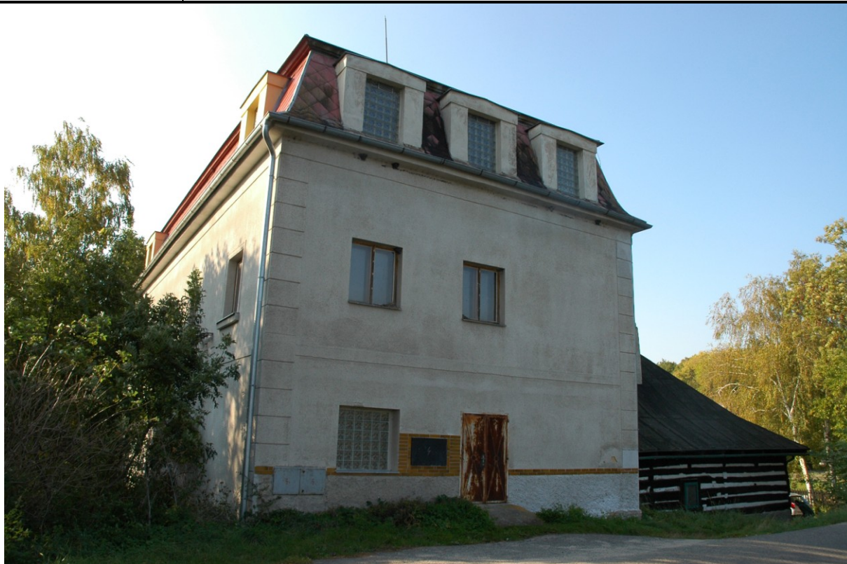
nová mlýnice, celkový pohled od jihovýchodu
