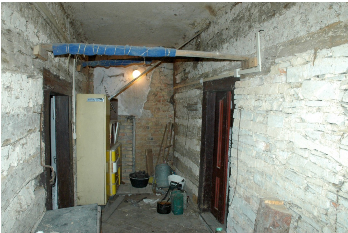
interiér střední chodby v místě někdejšího prostupu do zaniklého dílu mlýnice
