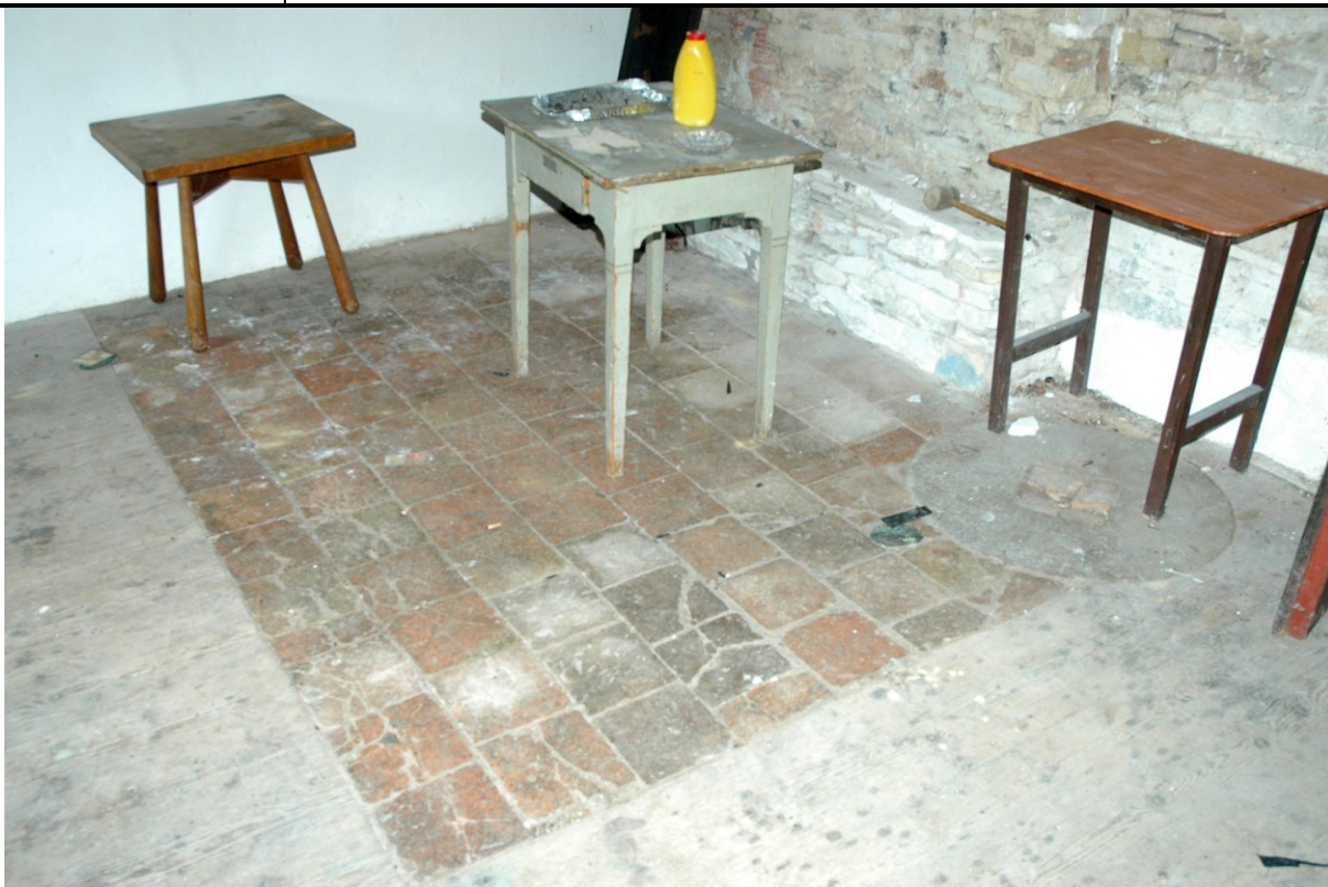
dlažba světnice v místě topeniště, s osazeným mlýnským kamenem
