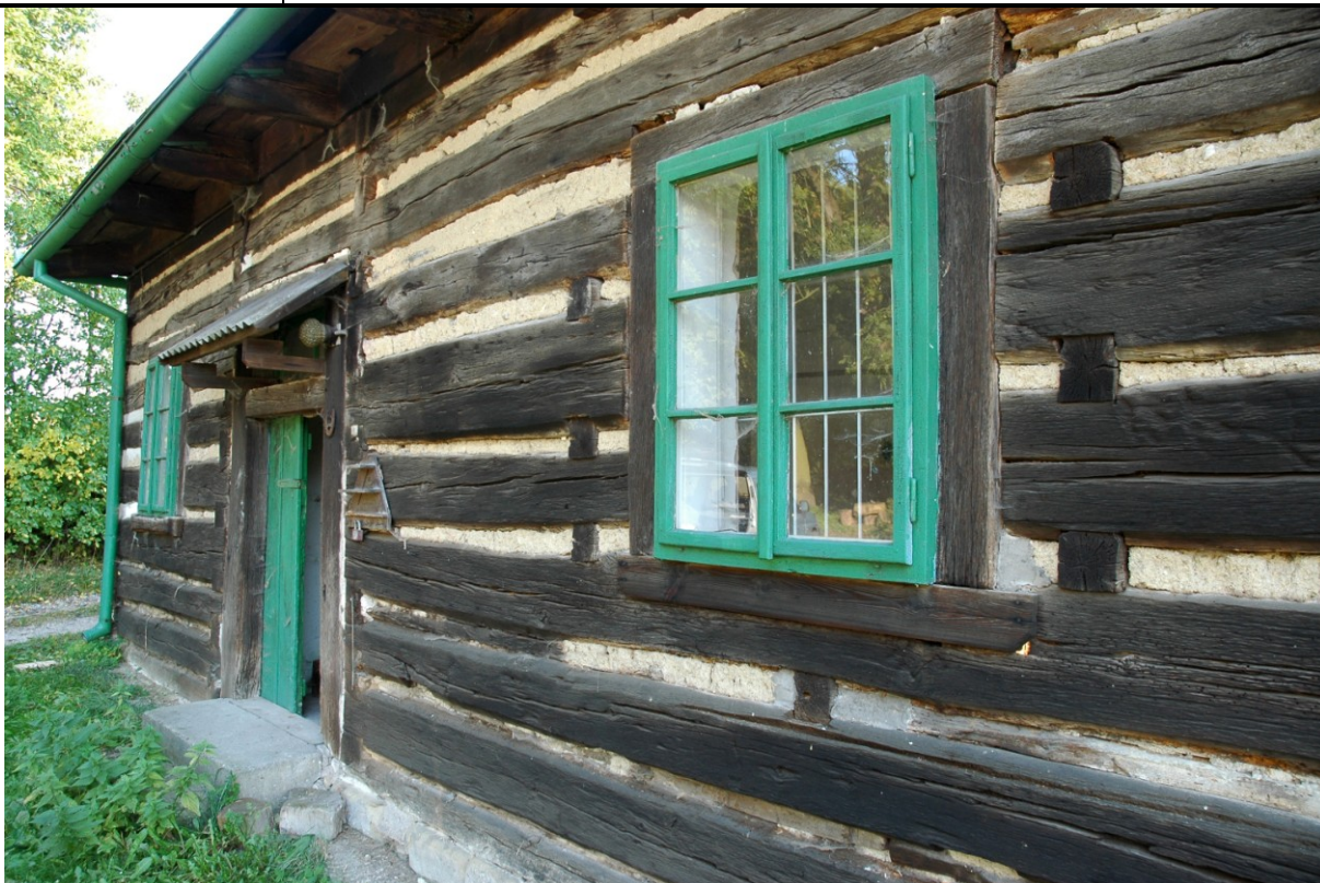
severní průčelí roubené části
