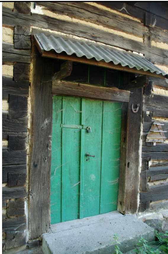
detail vstupního portálu v severním průčelí
