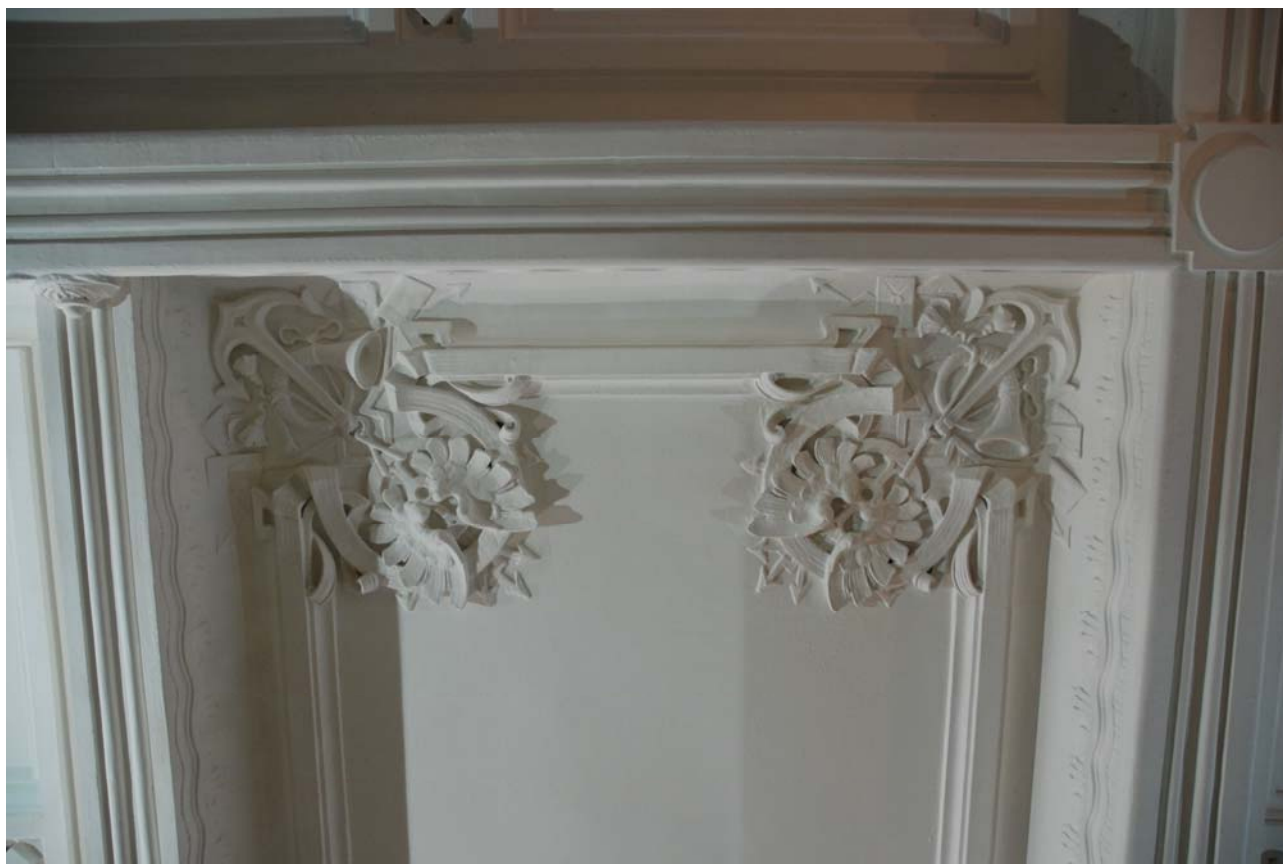
foto 0101125ps DSC_8752 – detail štukové výzdoby stropu poštovní haly se symboly poštovního úřadu
