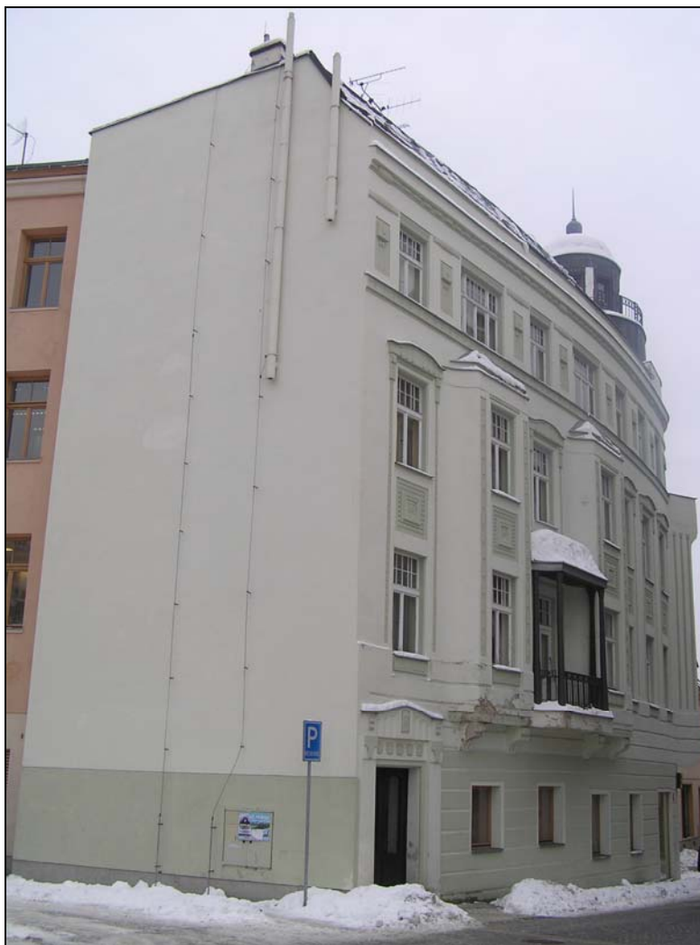
090112hl 006, severozápadní nároží
