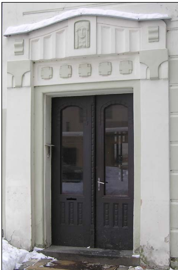
090112hl 004, západní fasáda – detail hlavních vstupních dveří
