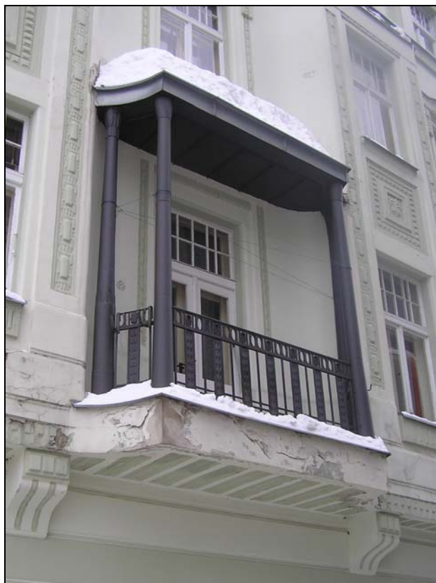
090112hl 005, západní fasáda – detail balkónu
