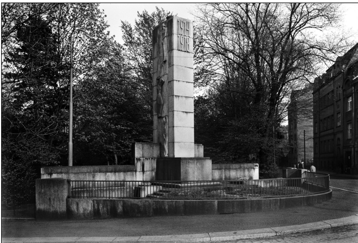
Historická zástavba Sadové ulice před demolicí, dům č.p. 145 první zprava (část), fotosbírka NPÚ, ÚP NO84369
