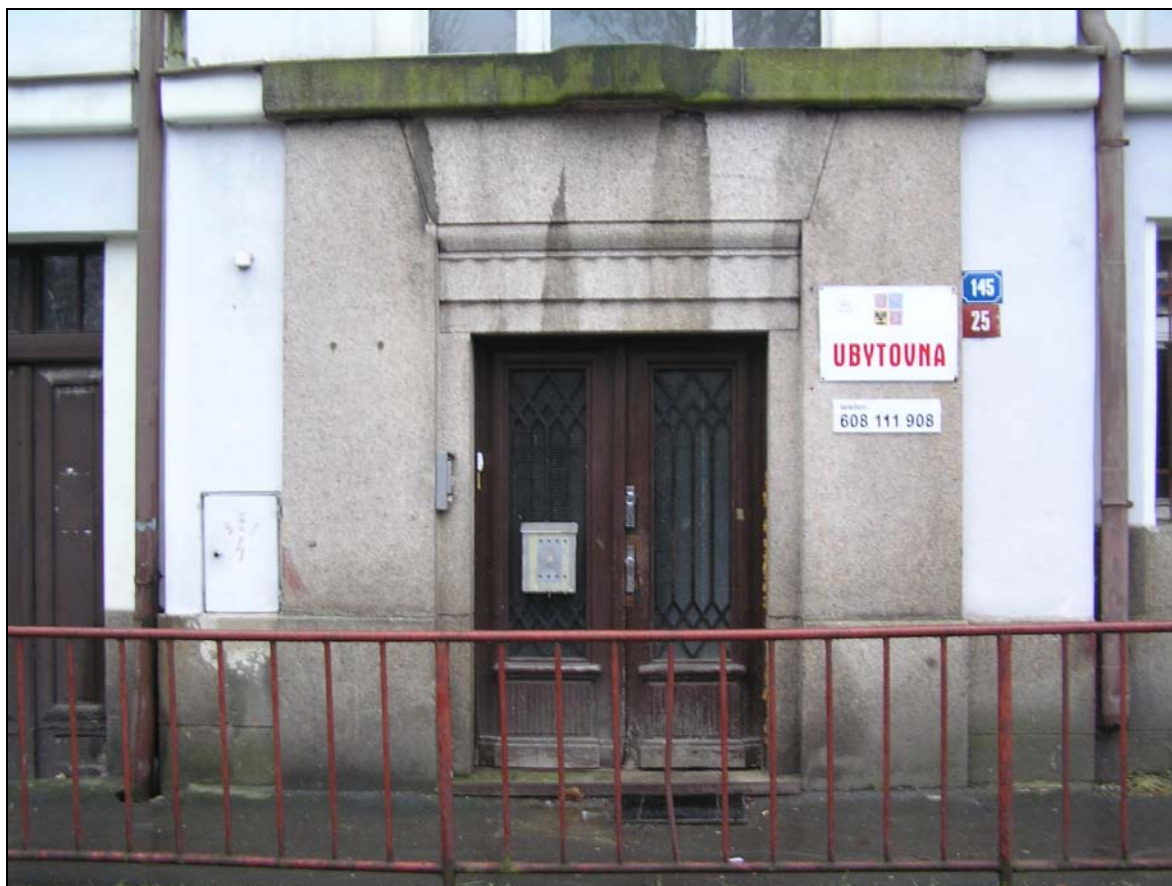
081215hl PC150004, severovýchodní fasáda – detail hlavního vstupu
