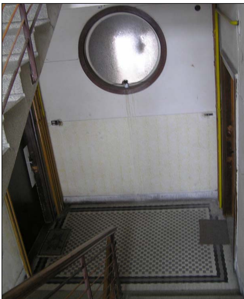
06hl 006, interiér - schodiště
