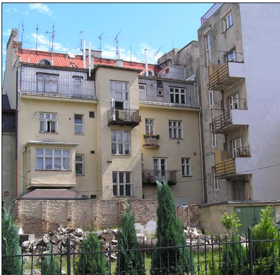
0808hl 026, severní zadní fasáda domu (v pravé části fotografie)
