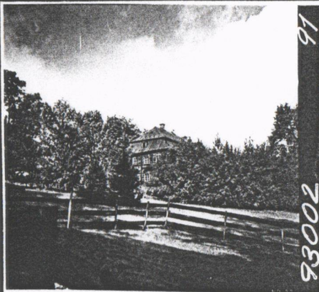
1991 pohled na část štítové stěny a mansardovou střechu
