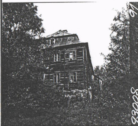
1991 detail roubené štítové stěny
