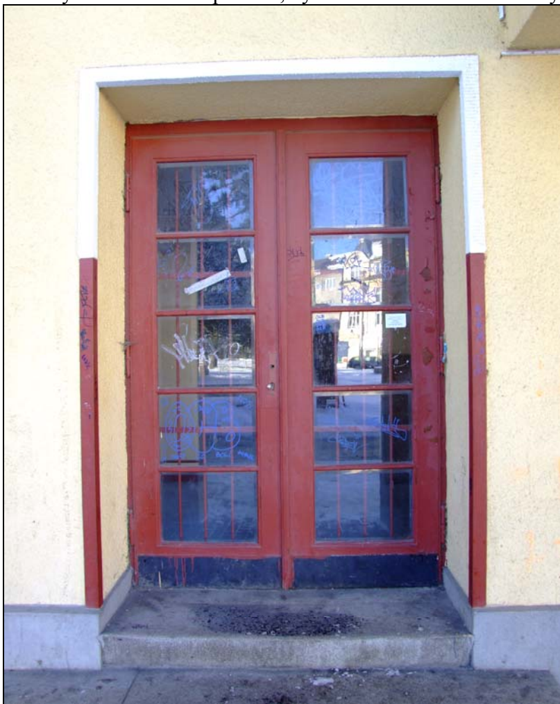
Aš, Masarykovo náměstí č.p. 1995, bývalé kino – vchodové dveře do objektu
